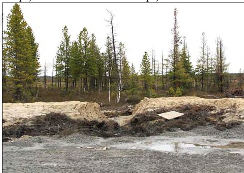
Рис. 3. Разрушение обваловки заполненного шламового амбара и поступление бурового шлама на прилегающую территорию, Пырейный ЛУ (фото автора).
