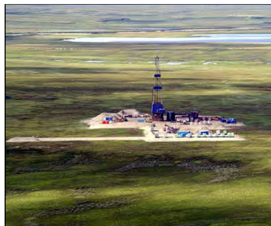
Рис. 2. Площадка поисково-оценочного бурения, Северо-Парусовый ЛУ (фото автора).
